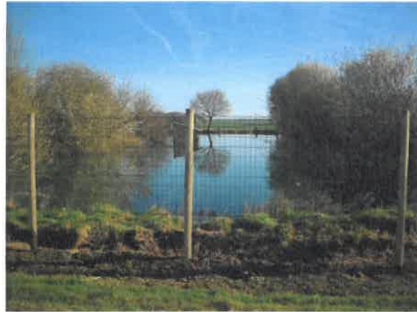
Réserve à incendie de 4 700 m3
